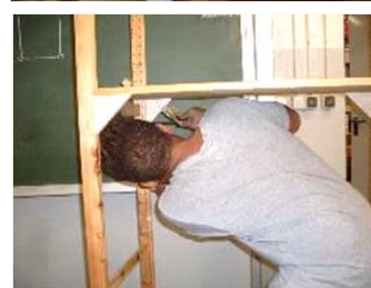
Eckenstabilisierung durch Dreiecke
