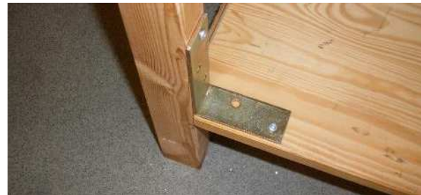
Eckenstabilisierung durch Winkel
